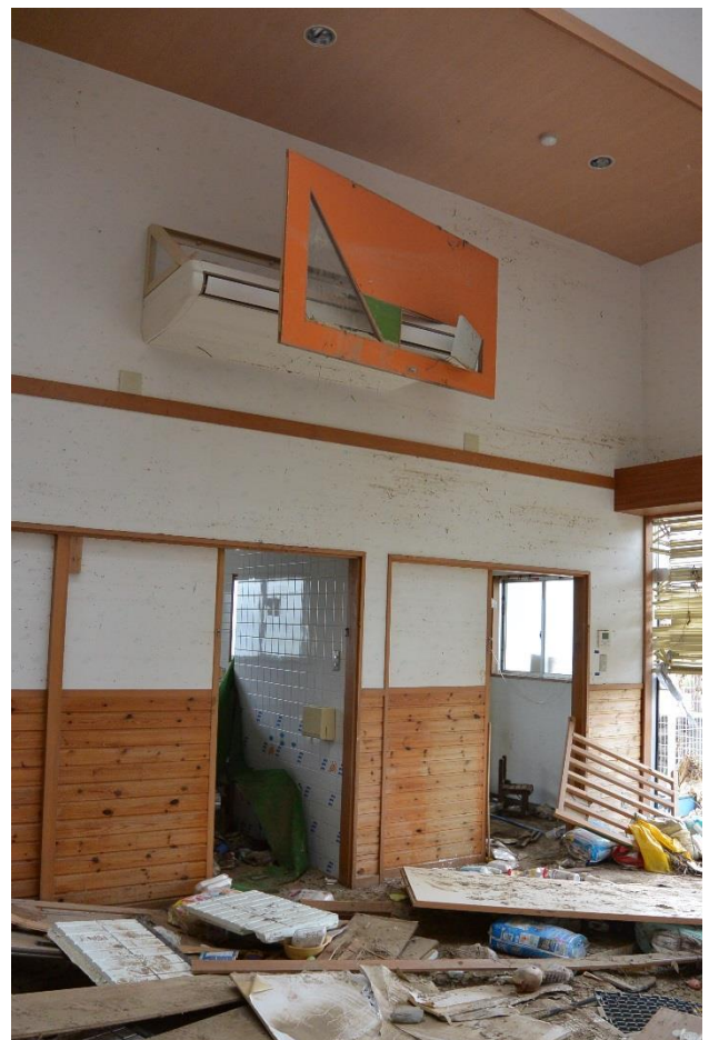
天井近くの空調に引っかかる扉（野村保育所）
