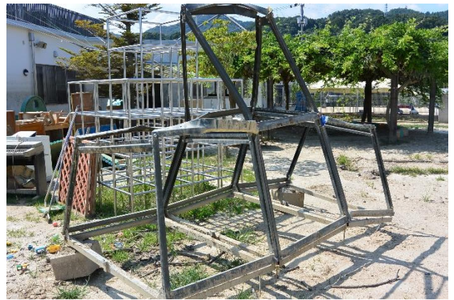
土台から流出した園庭の遊具。表面を覆っていた木製部分も浸水により流出（本郷ひまわり保育所）
